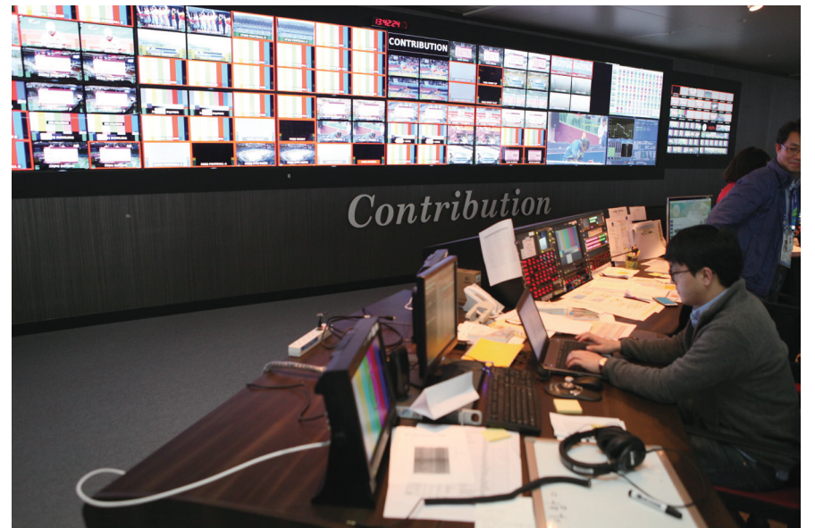
국제방송센터(IBC) 인천아시안게임에서 가장 주목할 곳은 MMC의 국제방송센터(IBC)다. 특히 이번에는 개별 장비 위주로 구성되던 시스템에서 벗어나 VSM(Virtual Studio Management) 시스템을 구축했다. 쉽게 말하면 전체 장비를 하나로 모아 도식화된 통합관제시스템이라고 이해하면 된다. 철도 공사에서 전체 지하철의 움직임을 한눈에 파악하듯이 모든 장비의 운영을 한곳에서 확인해 문제가 생겼을 경우 빠르게 대처할 수 있다. VSM에서 빼놓을 수 없는 부분이 스케줄러 기능이다. 스케줄러 기능은 방송국의 자동송출시스템과 똑같다고 보면 된다. 각 경기장에서 약 70여 개의 국제 신호들이 들어오는데 이 신호들을 받아서 원하는 국가와 방송사에 자동으로 전송하는 것이다.
